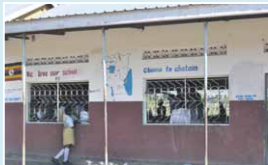
Nové triedy Základnej školy sv. Cypriána postavené z prostriedkov Dobrej noviny
