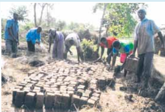
Farníci v Ngoma chystajú tehly na stavbu nového internátu.
